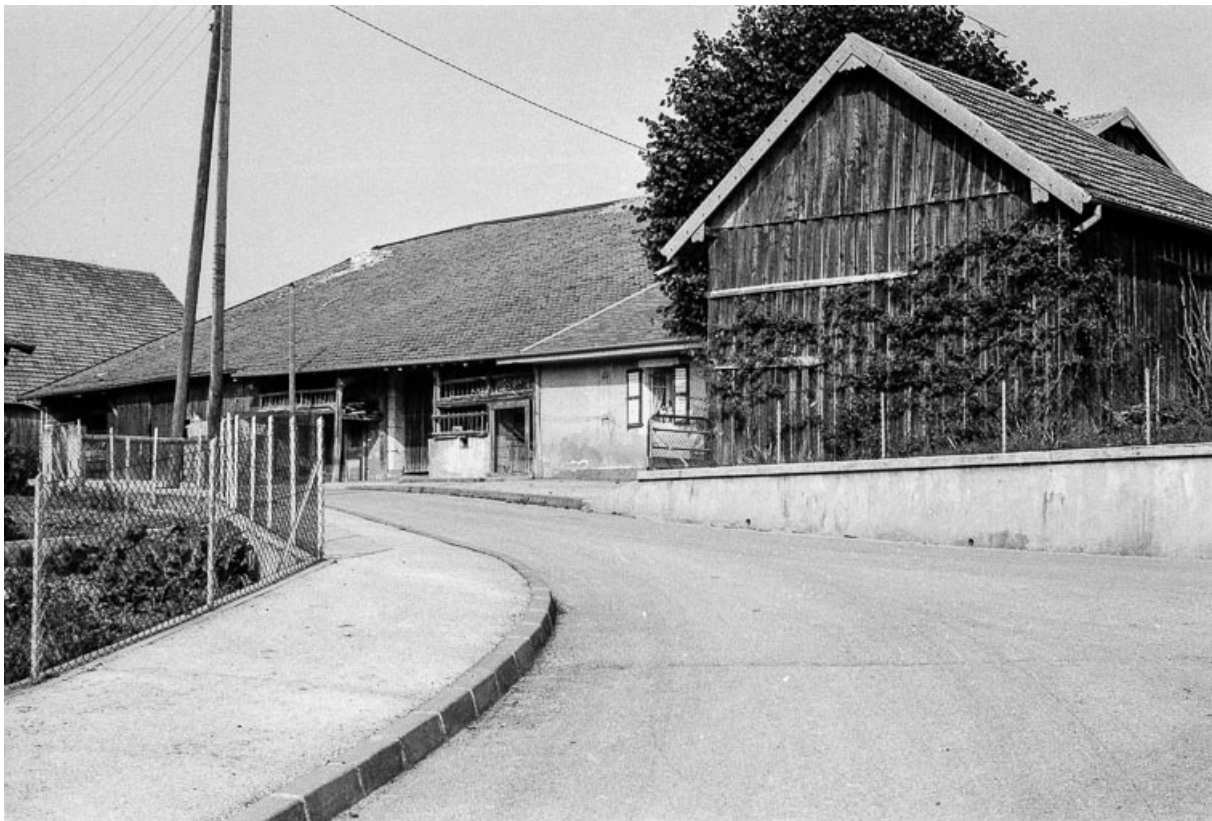
Ferme : vue d'ensemble depuis la rue.
