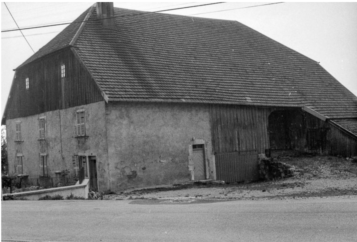
Ferme : façades antérieure et latérale droite.
