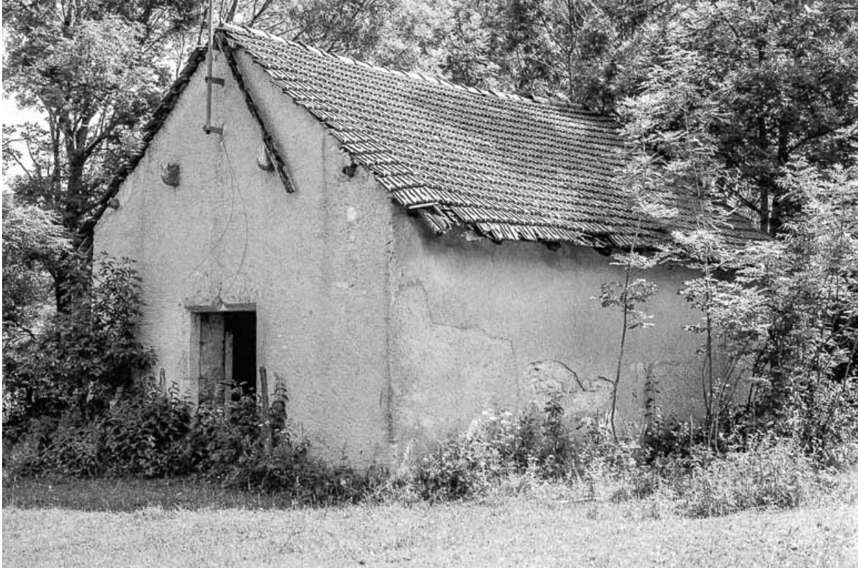
Extérieur : faces antérieure et latérale droite.
