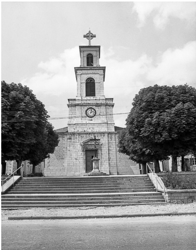
Extérieur : face antérieure.
