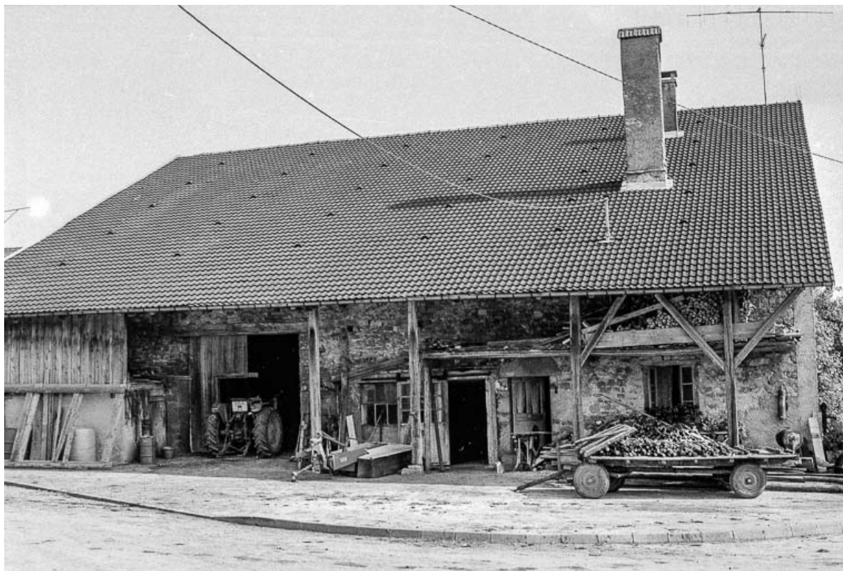
Gouttereau sur rue. 25, Évillers
