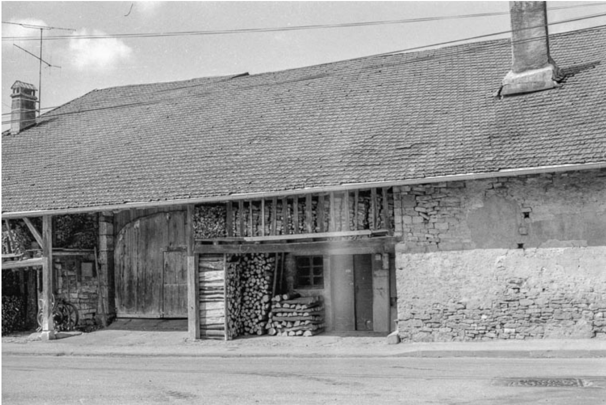
Détail de la façade sur rue.
