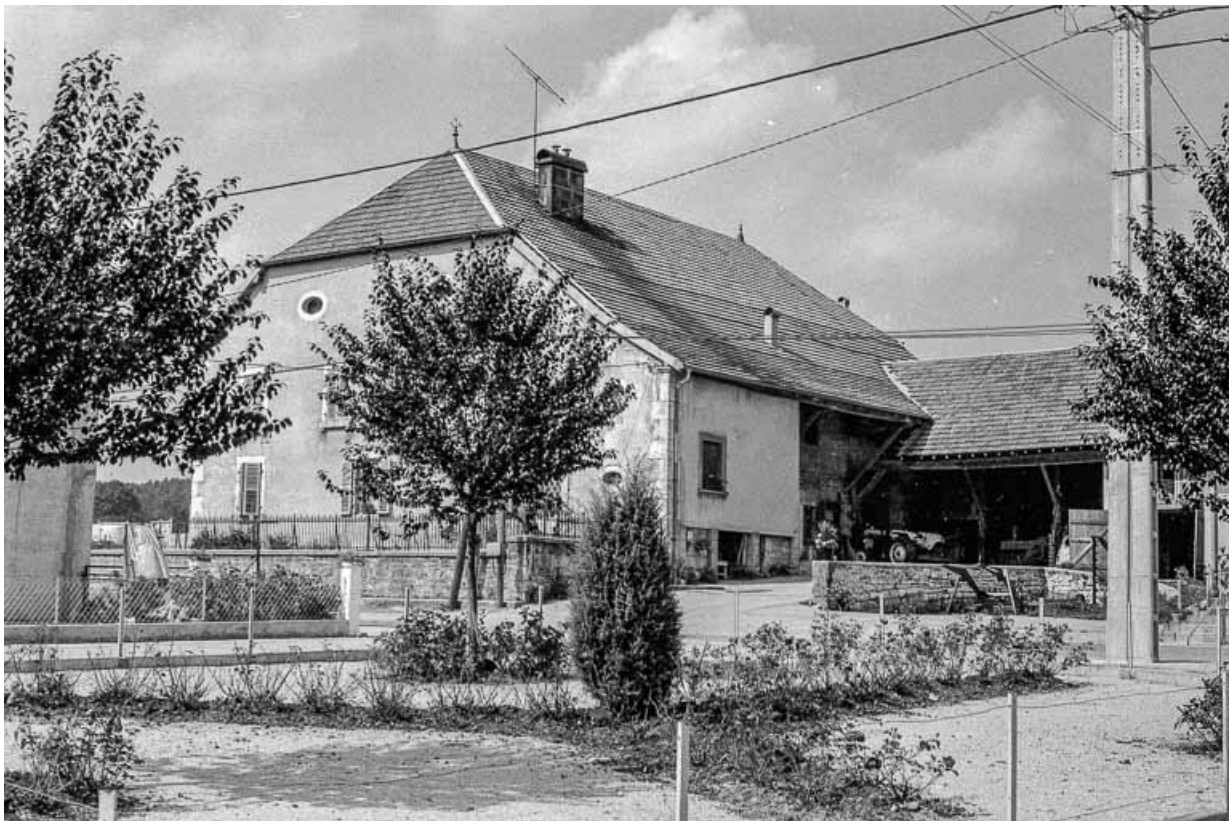
Façades sur cour.
