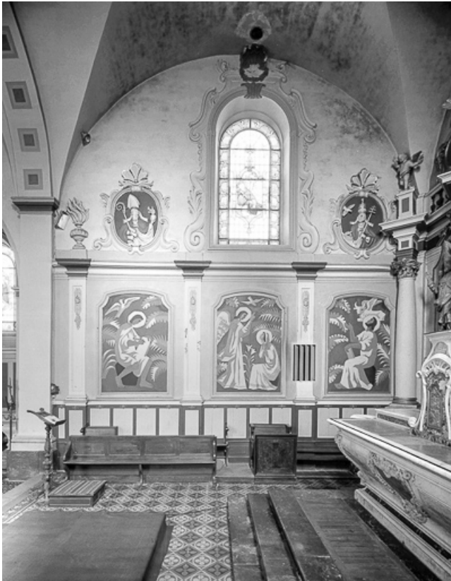
Intérieur : mur gauche du chœur.
