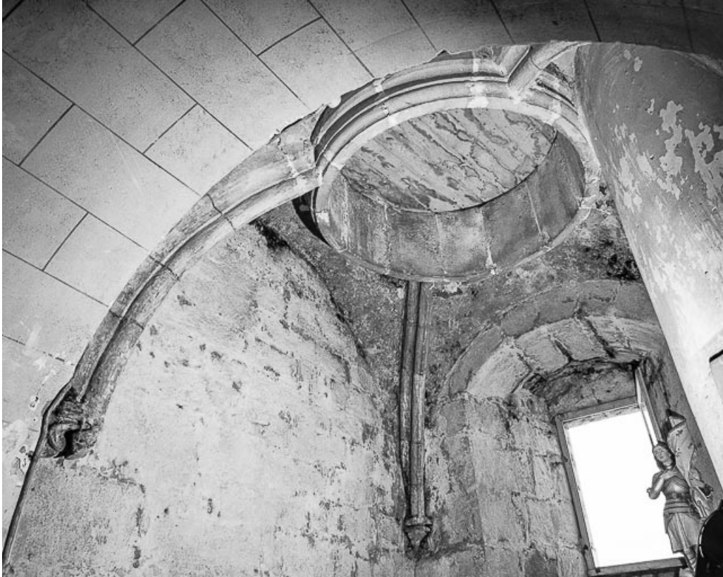
Clef de voûte.
