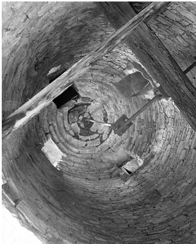
Intérieur de la tour : coupole et arbre.
