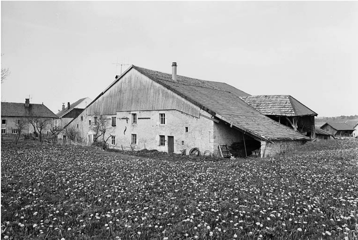
Extérieur : pignon de l'habitation et goutterot postérieur.
