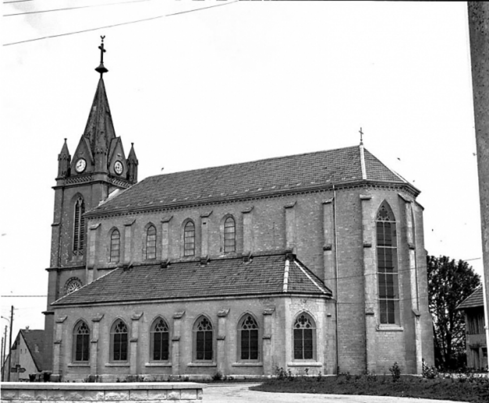
Façade latérale sud.
