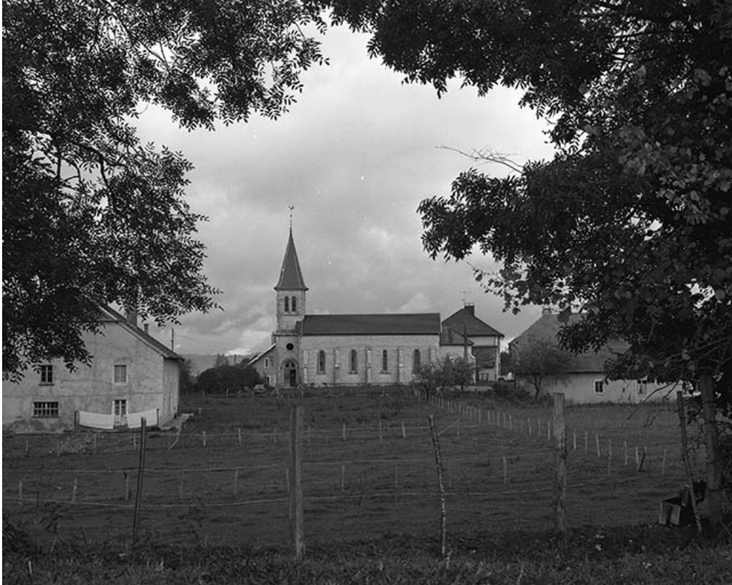
Façade latérale sud.
