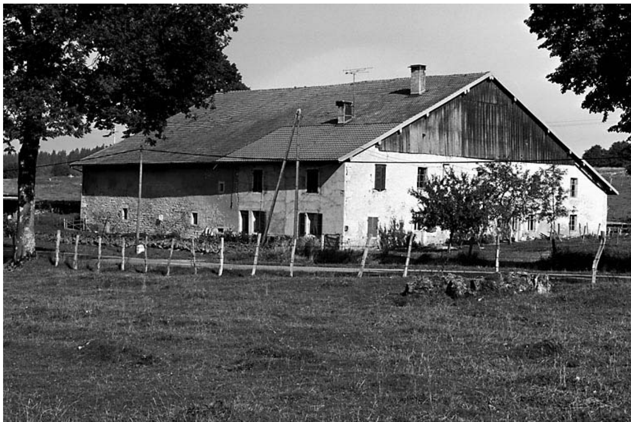
Façades antérieure et latérale gauche.
