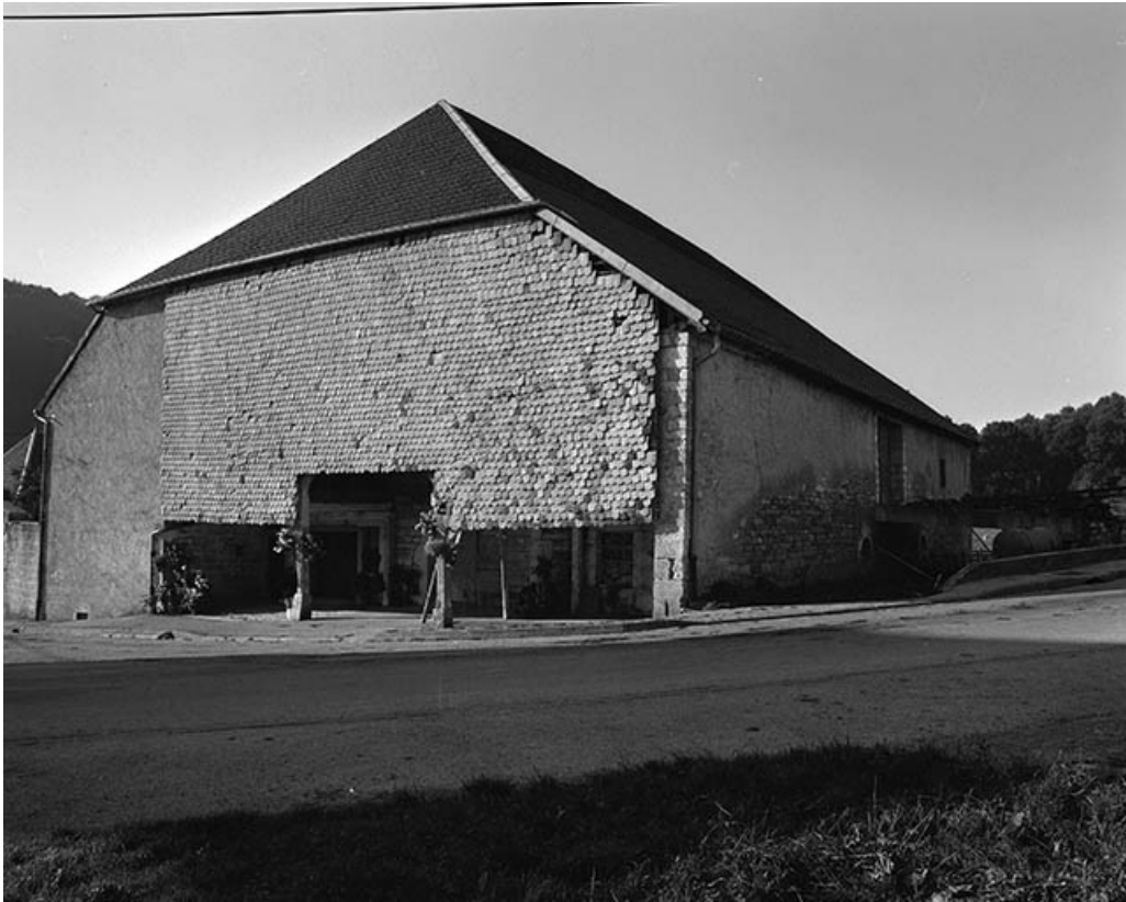
Façade latérale droite sur rue.
