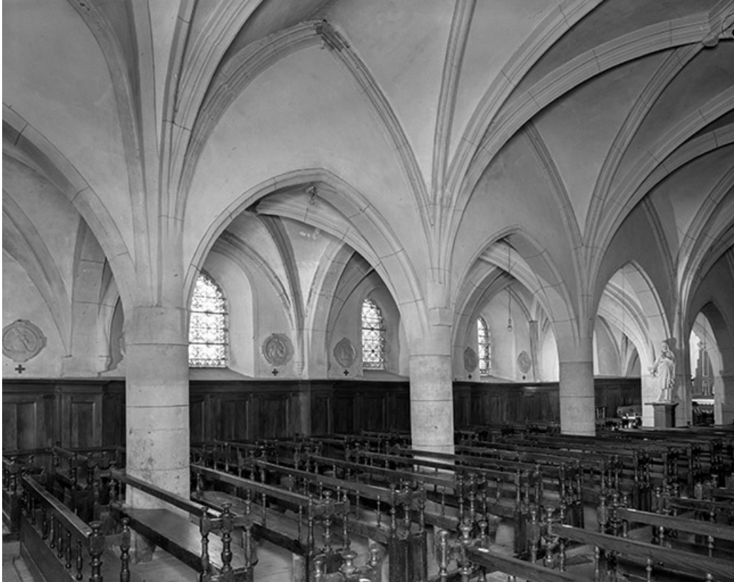
La nef, élévation nord.
