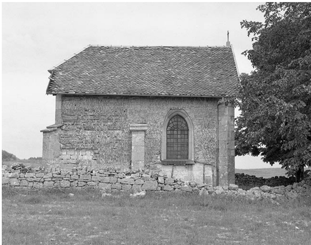
Façade latérale nord.
