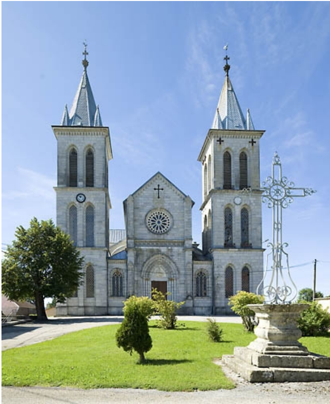
Façade antérieure et croix monumentale.
