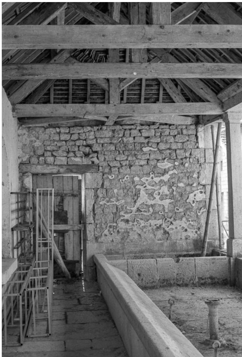
Intérieur : bassin et charpente.
