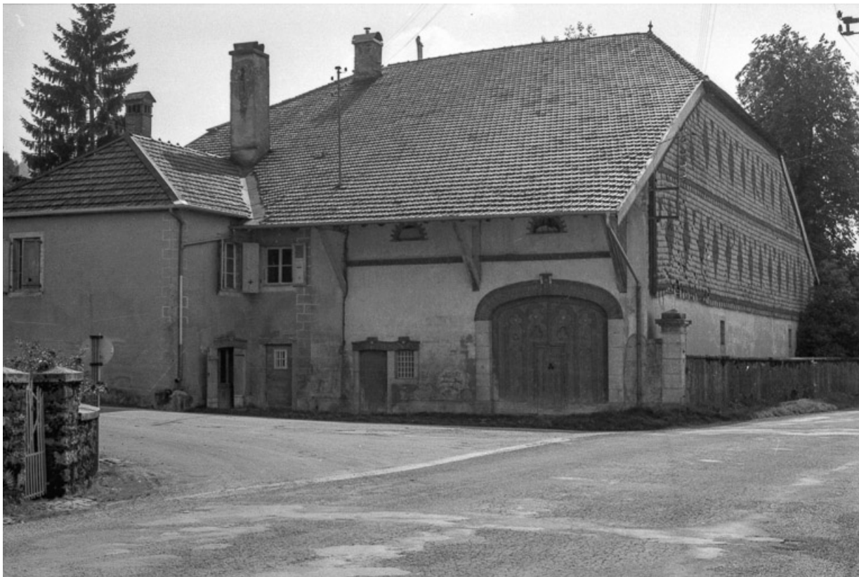
Façades postérieure et latérale droite.
