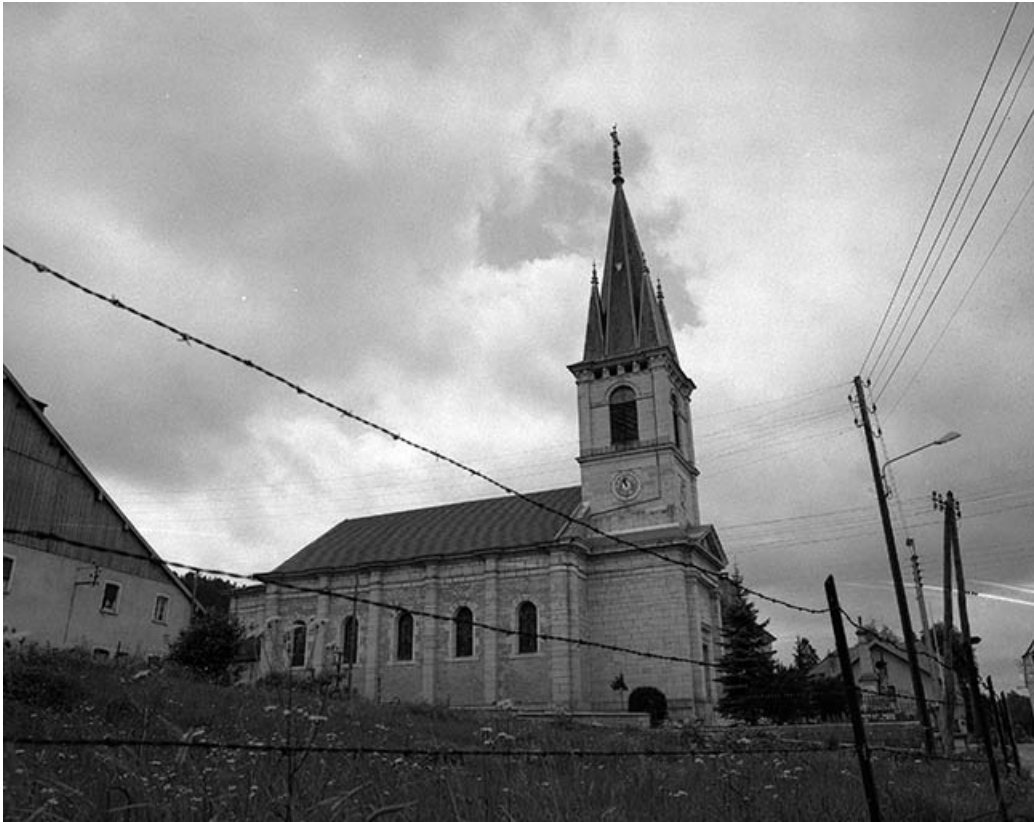
Extérieur : chevet et façade latérale gauche.
