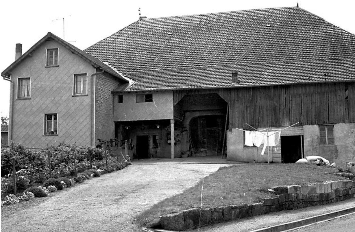
Vue du mur goutterot. 25, Arc-sous-Montenot
