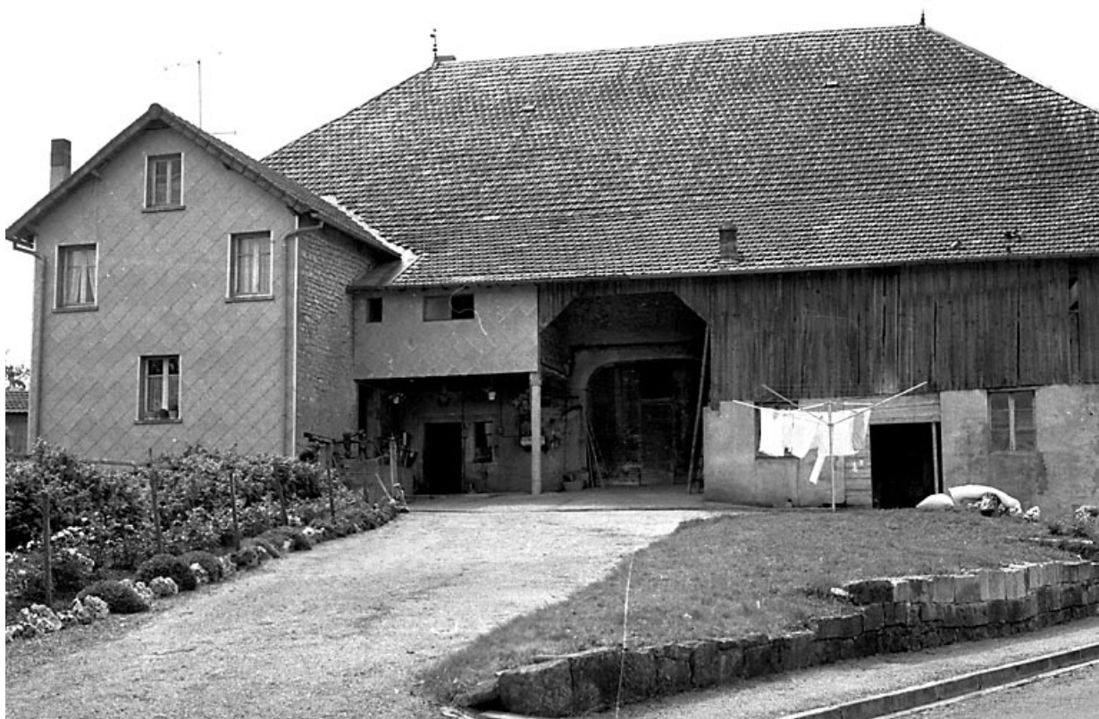
Vue du mur goutterot. 25, Arc-sous-Montenot
