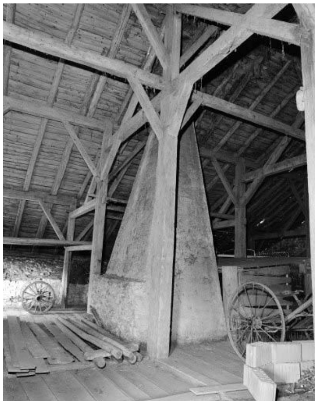
Charpente et conduit de cheminée.
