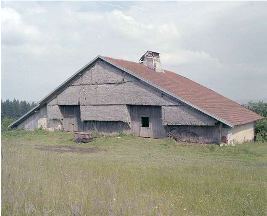
Façades postérieure et latérale gauche.
