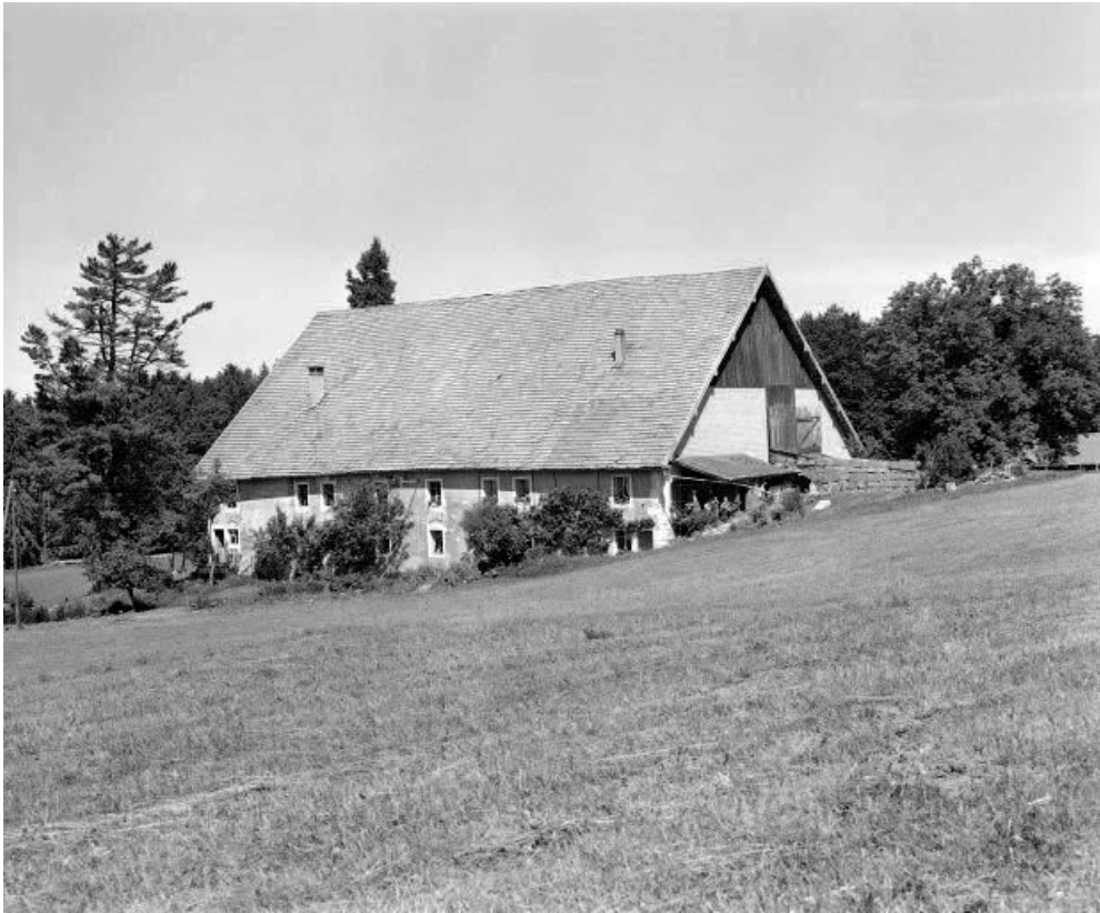
Façades antérieure et latérale droite.
