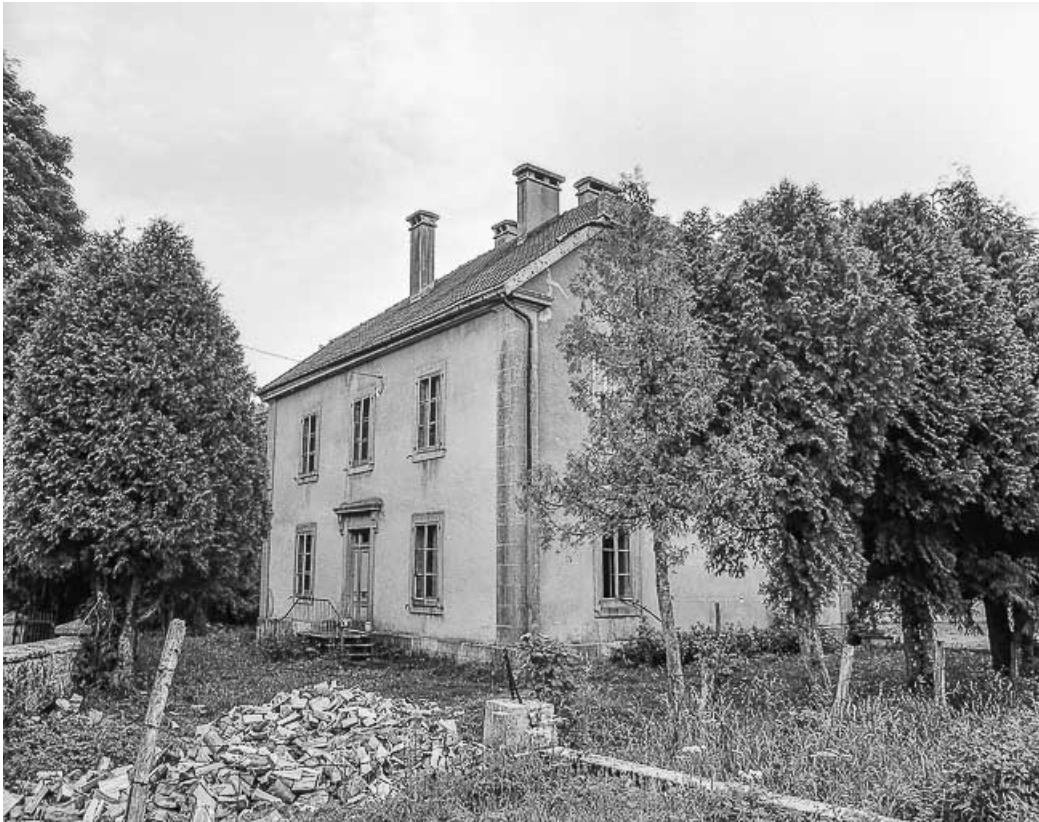
Montlebon, lieu-dit Les Fontenottes : vue d'ensemble.
