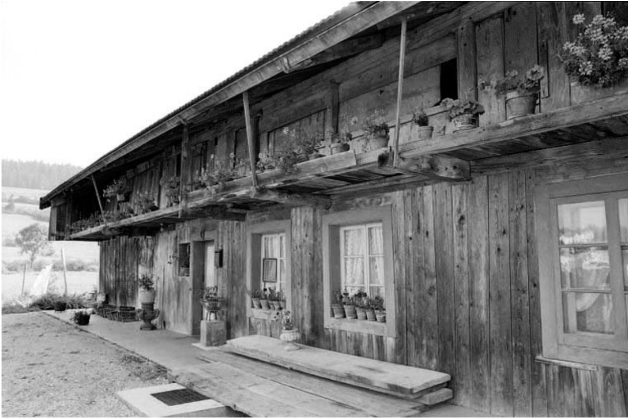
Ferme 5 : façade latérale.
