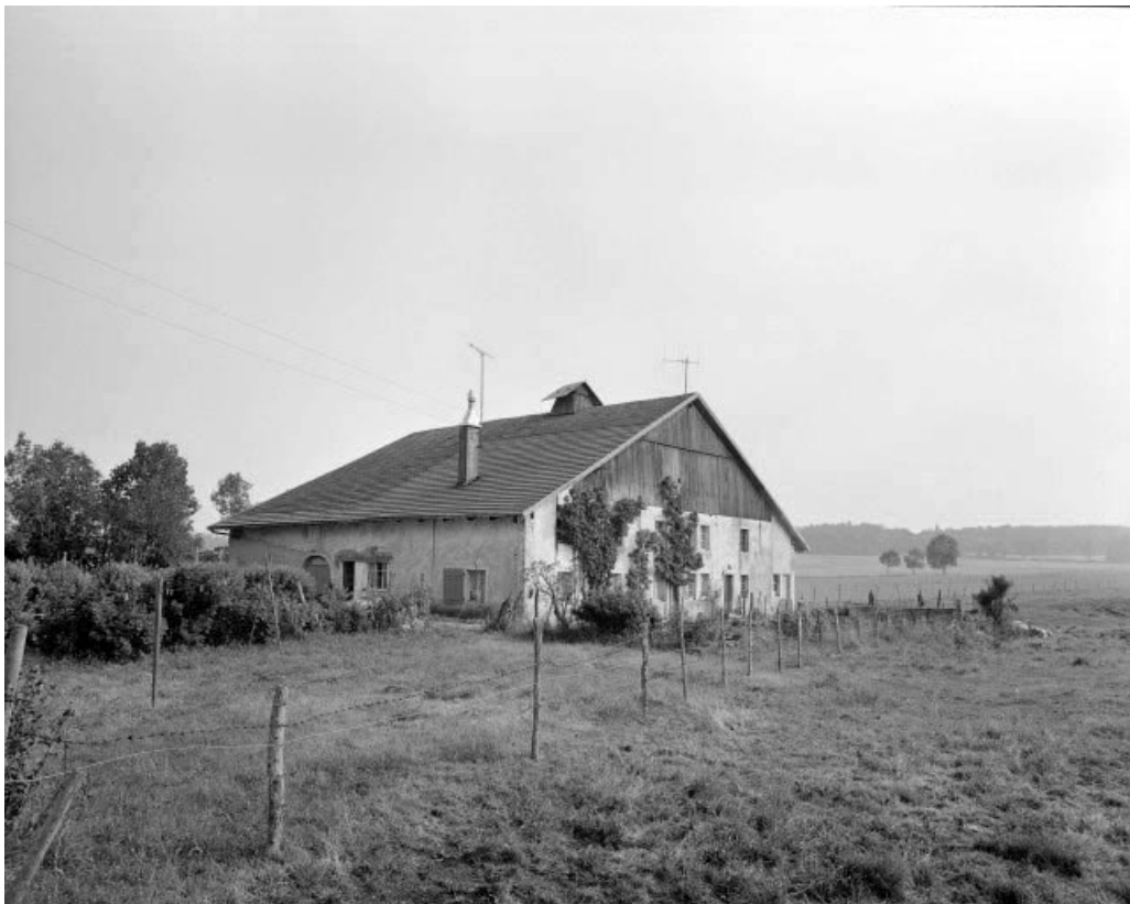
Façades antérieure et latérale gauche.
