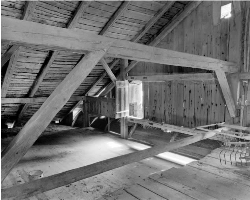
Charpente et lambreques antérieure à surplomb cintré.
