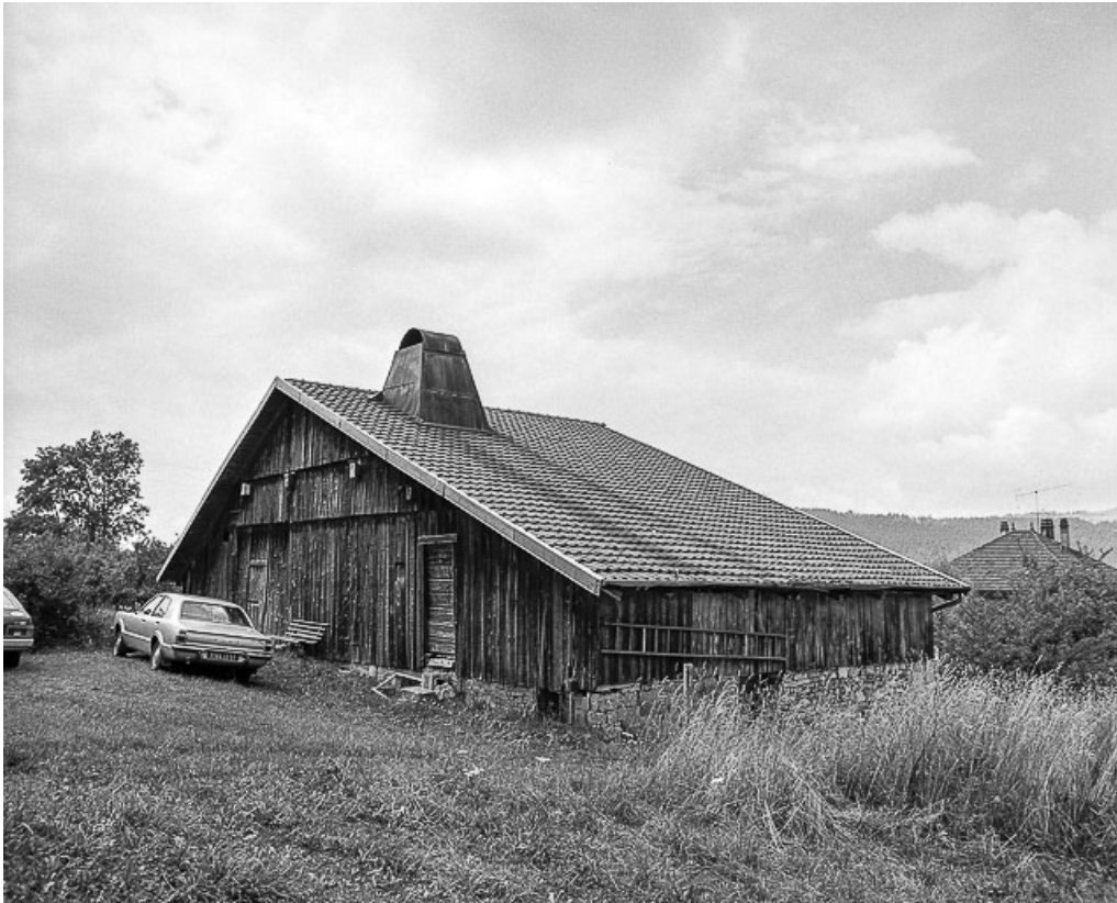
Façades postérieure et latérale gauche.
