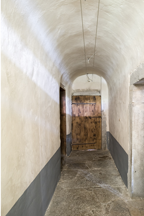
Couloir voûté (côté sud).
