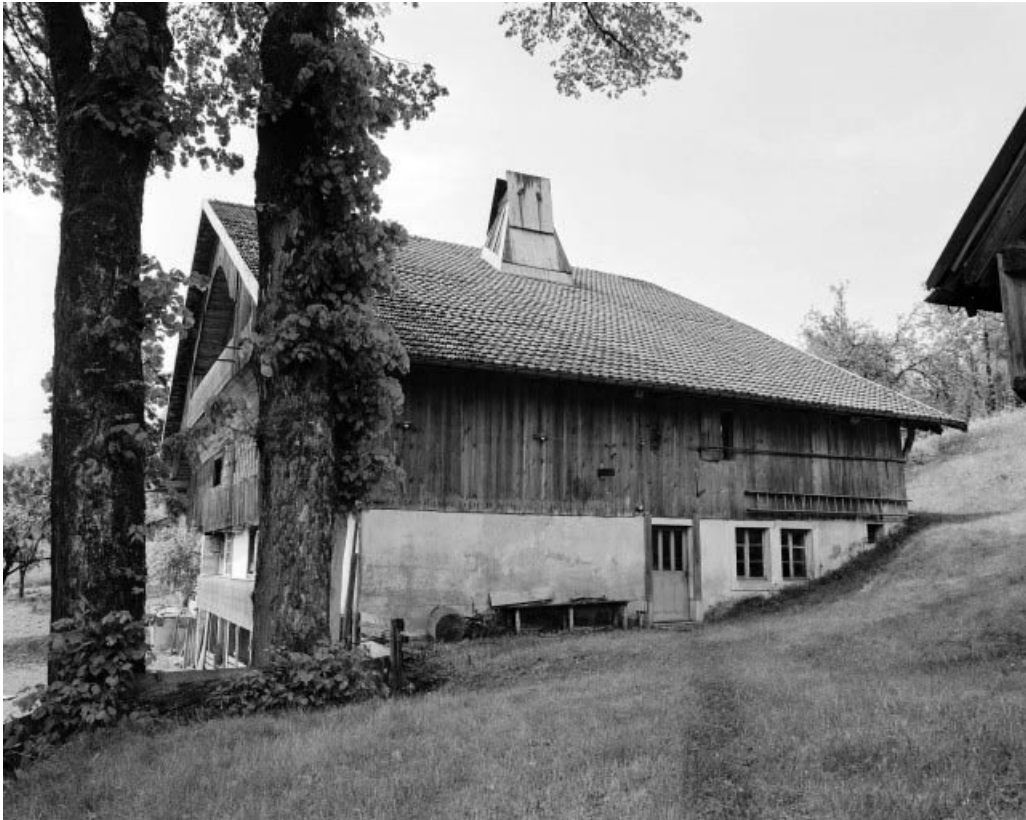
Extérieur : façades antérieure et latérale droite.
