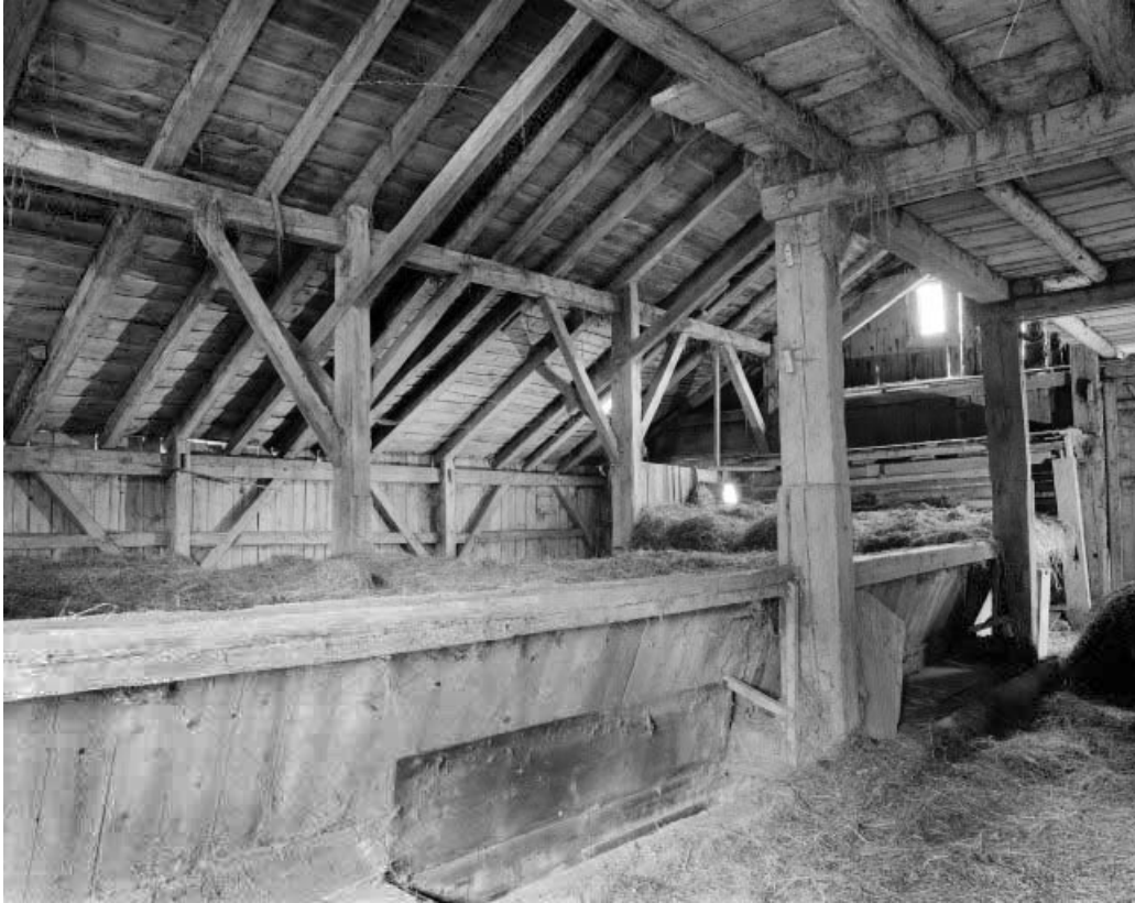
Charpente vue de l'aire de roulage.
