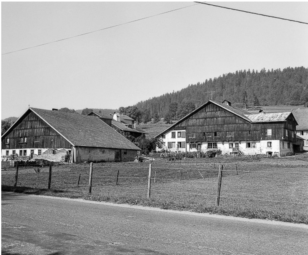
Vue de trois quarts, depuis l'est.
