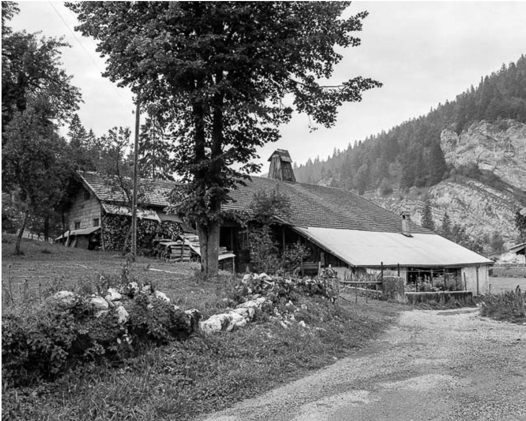
Façades postérieure et latérale gauche.
