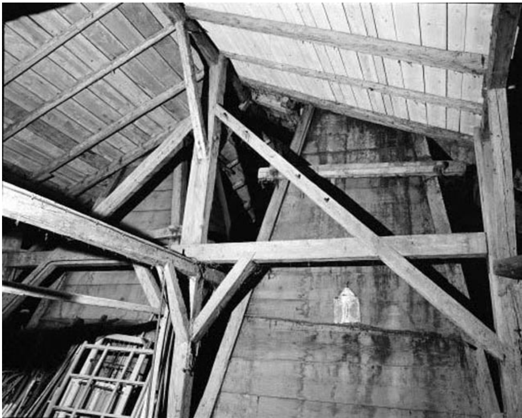
Intérieur : comble, fermes, charpente, hottes des "tués".
