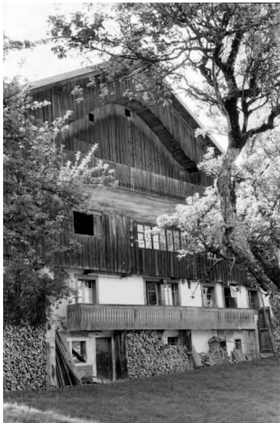
Extérieur : façade antérieure.
