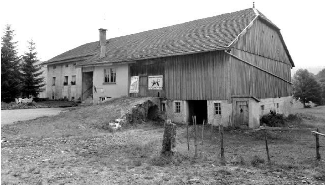
Façades postérieure et latérale gauche.
