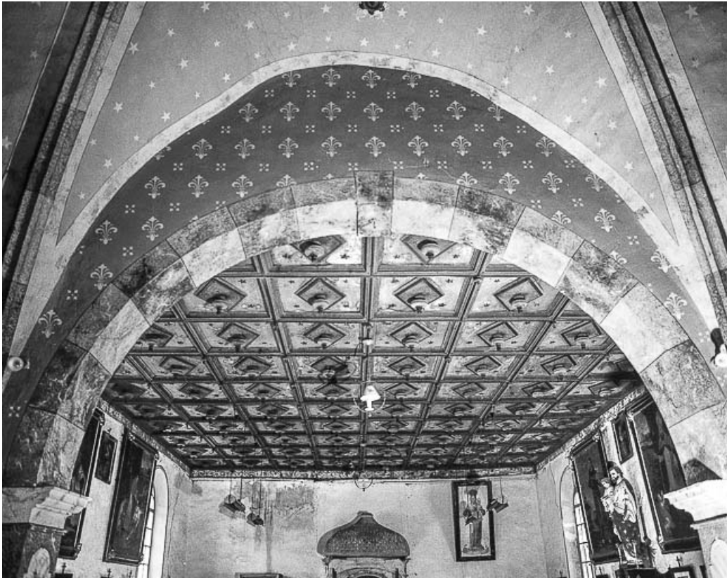
Plafond de la nef.
