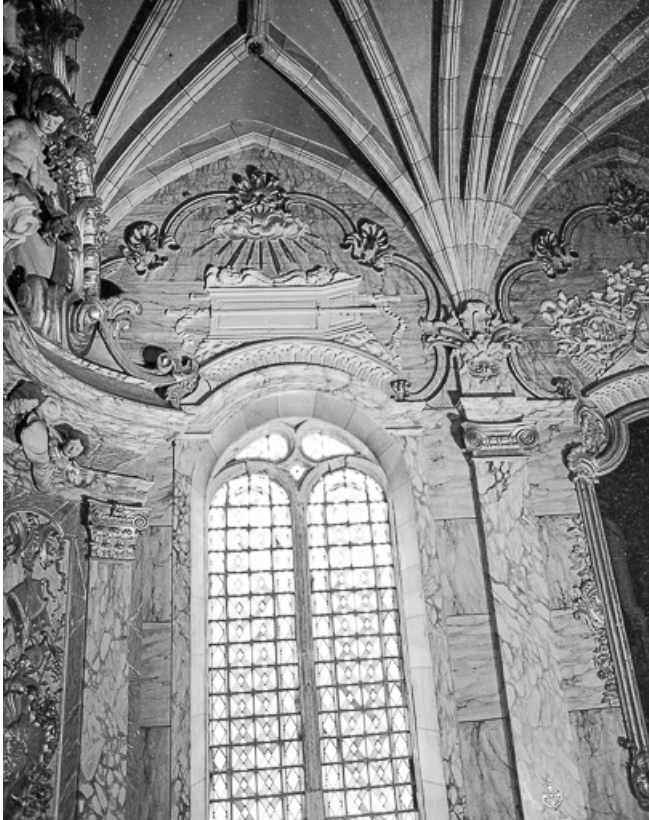
Mur droit, deuxième travée.
