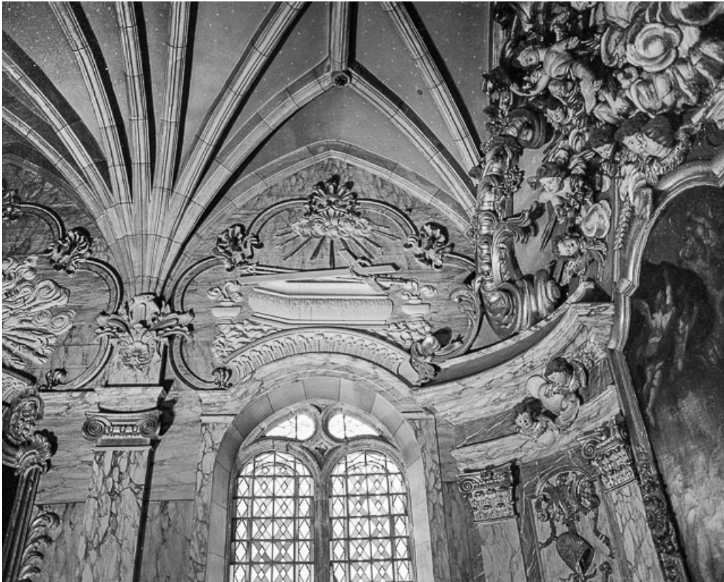
Mur gauche, deuxième travée.
