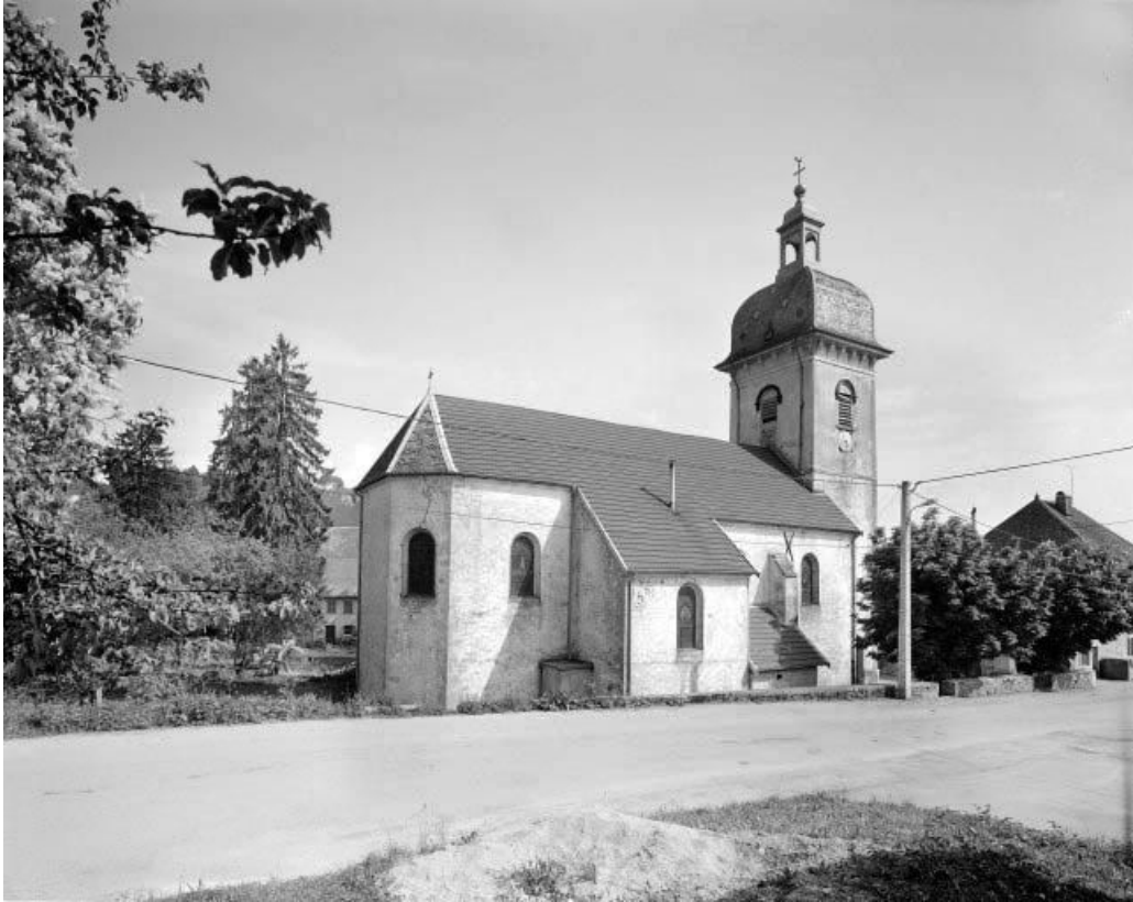
Façade latérale gauche et chevet.
