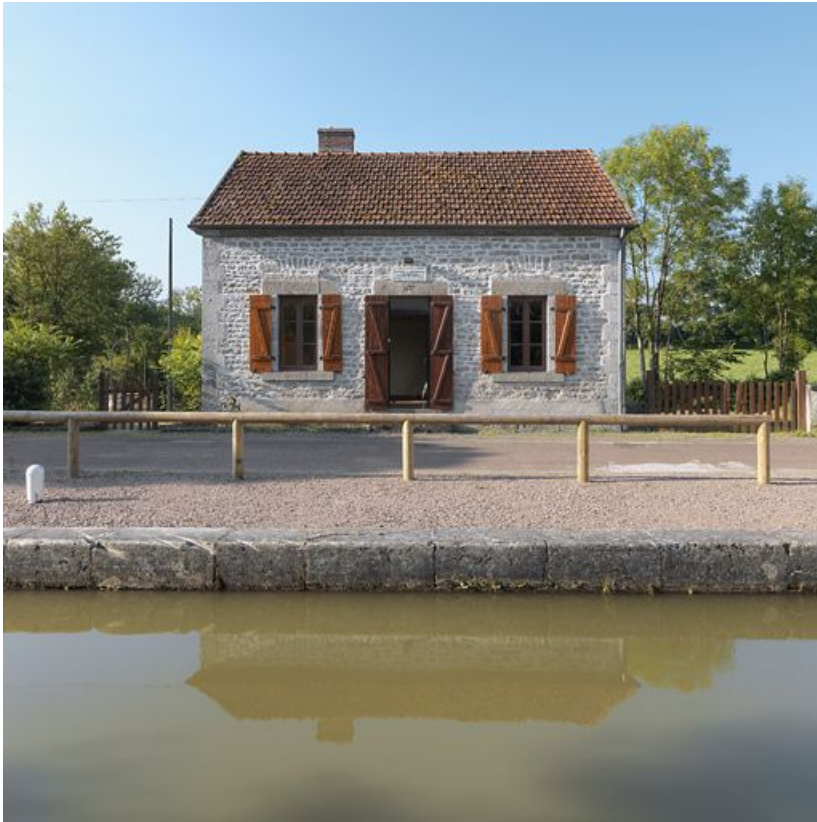
La maison éclusière : vue de face.
