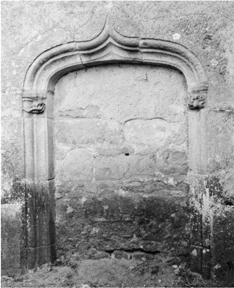
Porte latérale droite murée dans la nef.
