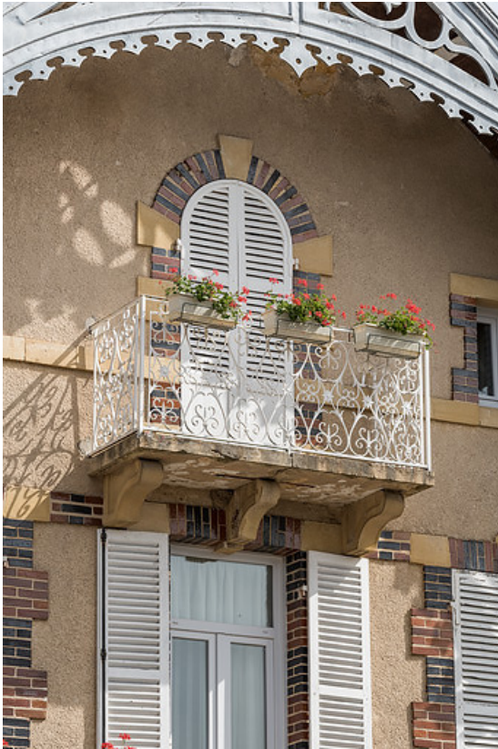
Baie et balcon du second étage.
