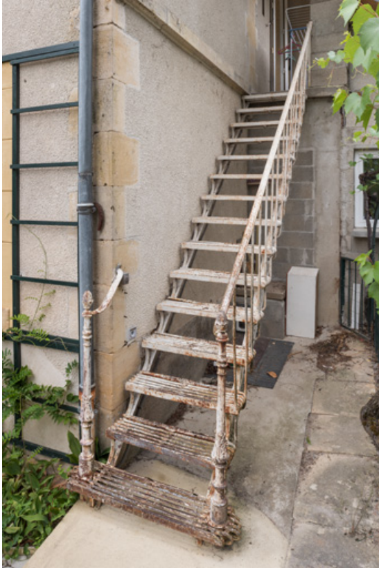
Escalier extérieur conduisant à l'étage.
