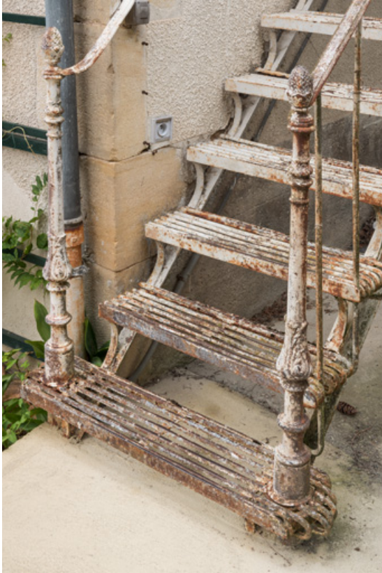
Escalier extérieur conduisant à l'étage, détail.
