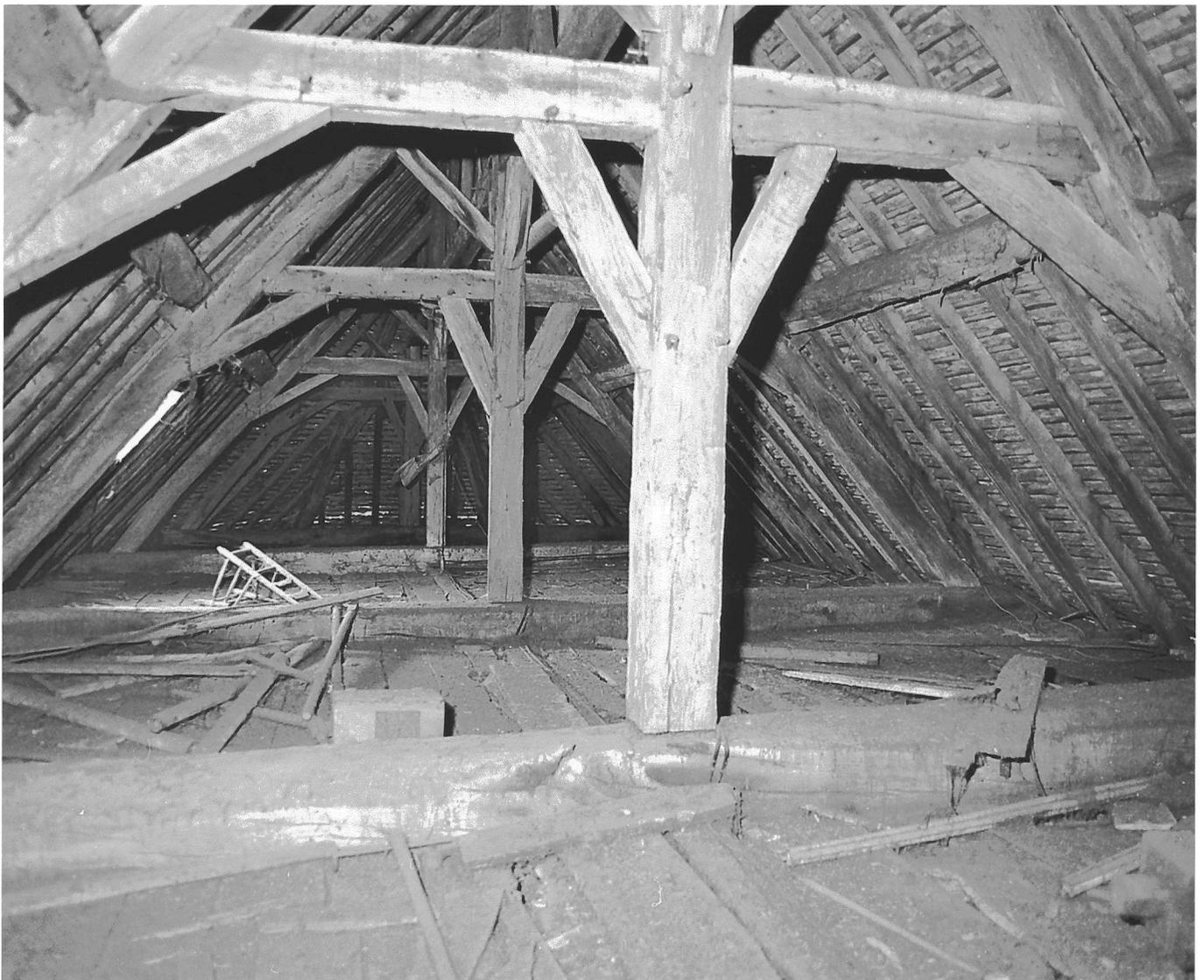
Fig. 09 Charpente de la nef, détail du contreventement.
