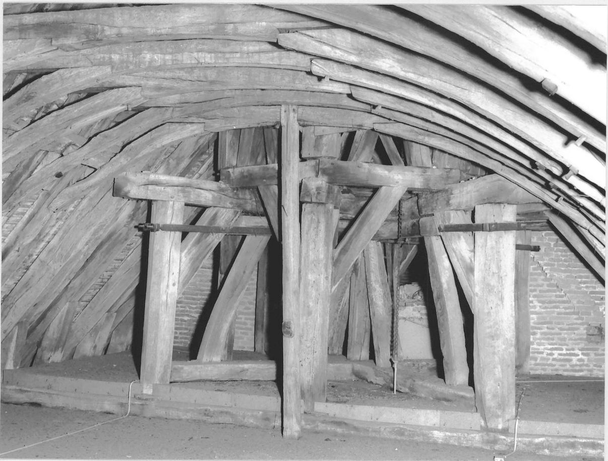
Fig.25 Charpente du comble et beffroi
