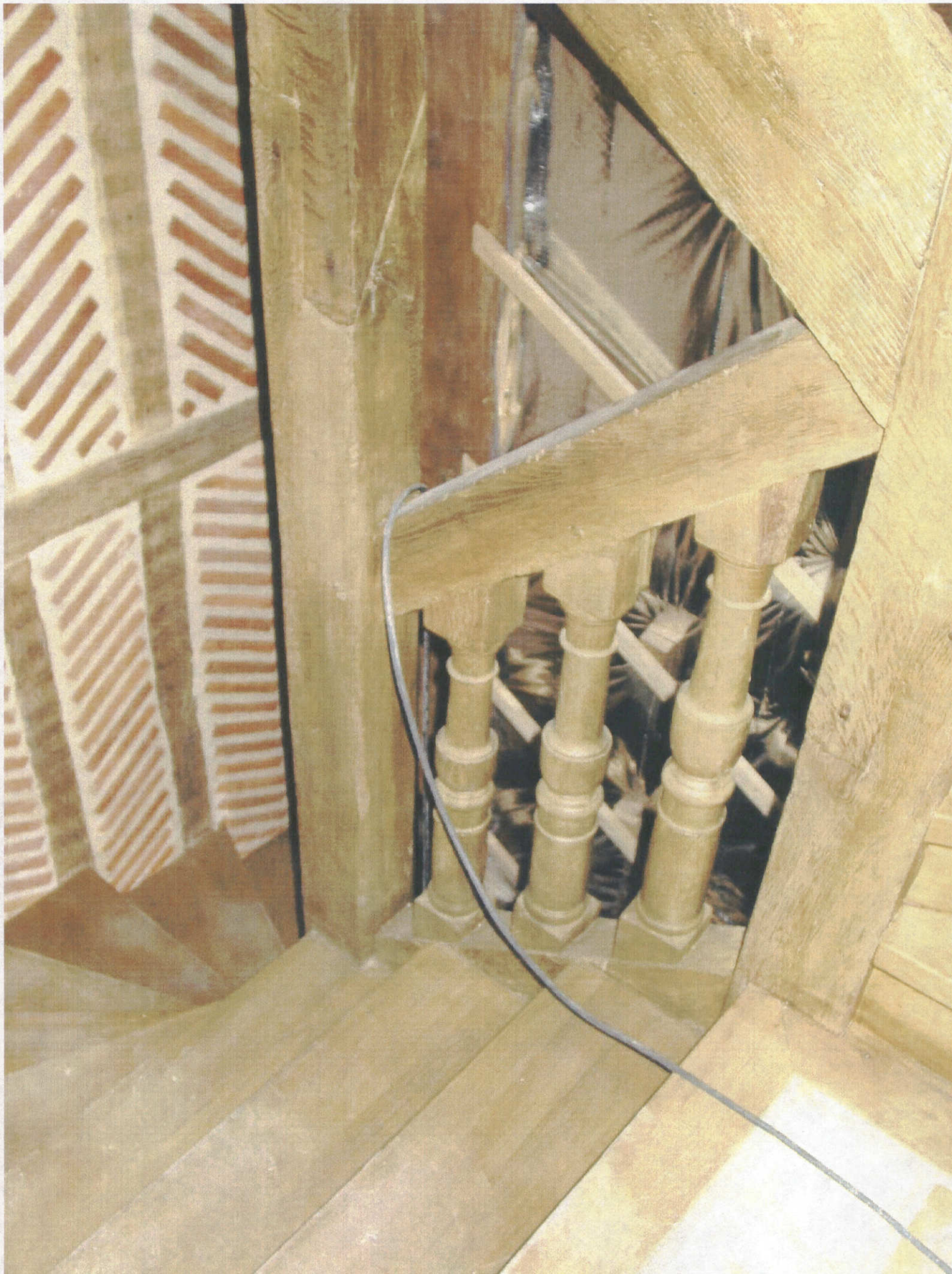
Escalier 4 er niveau
