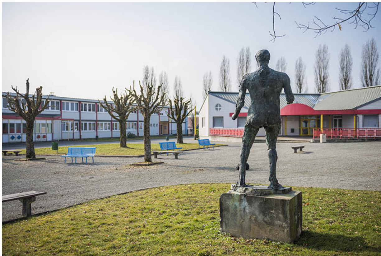
Vue d'ensemble de la face postérieure.
