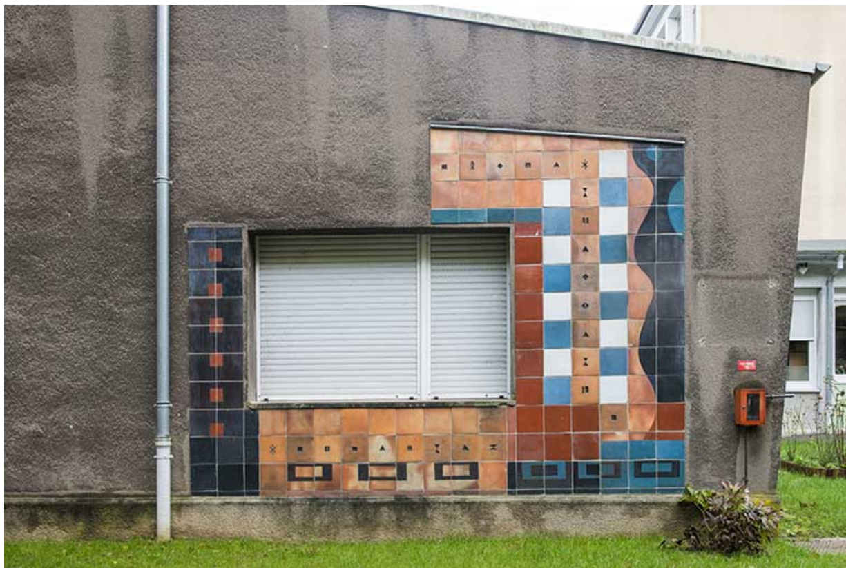
Oeuvre de Bizette. Façade sur rue.
