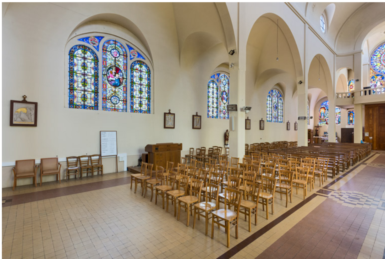
Verrières de la façade est (Baies 104, 106, 108 et 110). Vue d'ensemble de trois quarts. 89, Migennes, 3 avenue Marcelin Berthelot
