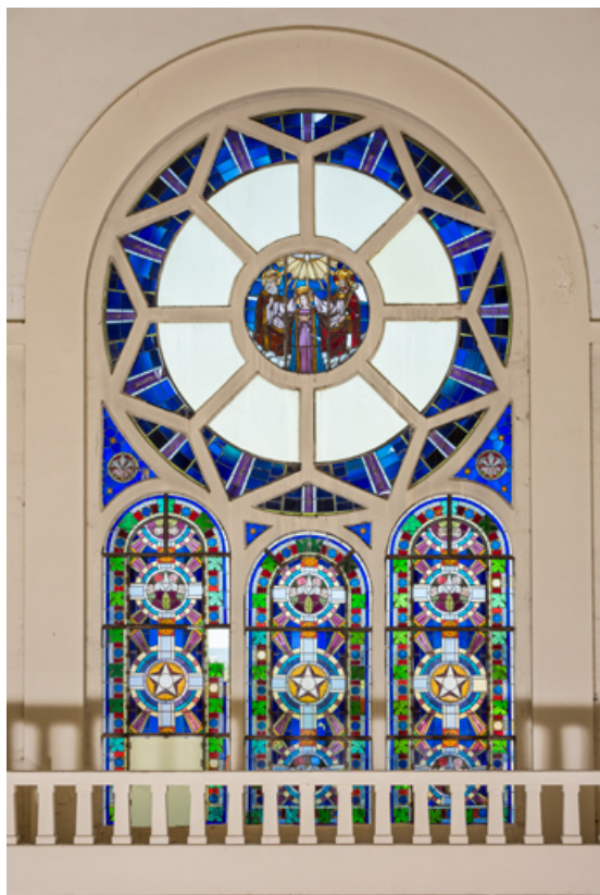
Verrière de la baie 101. Vue d'ensemble.
