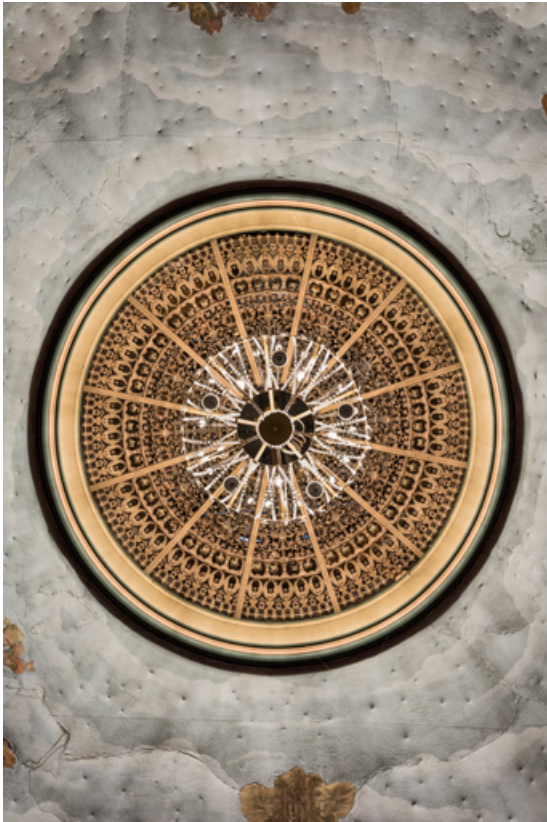
Grille métallique de l'oculus surmontant le lustre.
