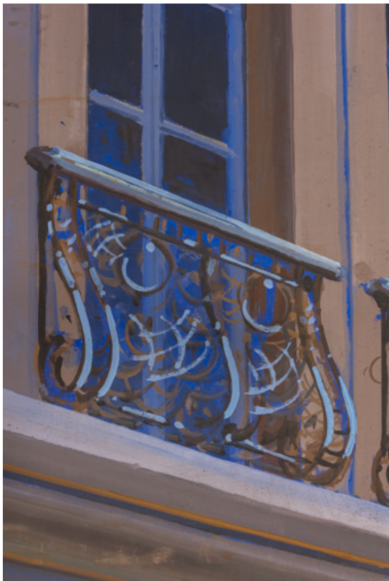
Place publique : châssis du 1er plan, côté jardin. Détail : garde-corps du balcon. 71, Louhans, 88 Grande Rue
